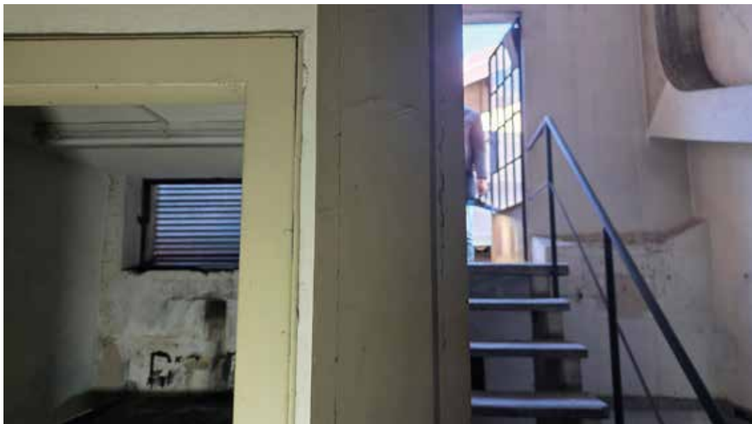
Spazio Oderon: il vano scale che porta sopra la copertura del Cinema Teatro, a fianco della Stanza di proiezione cinematografica (non visibile a destra)
